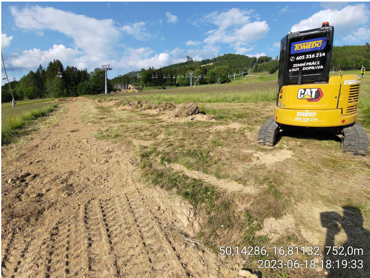
Obrázek 7: Malý bagr provádějící zemní práce.
