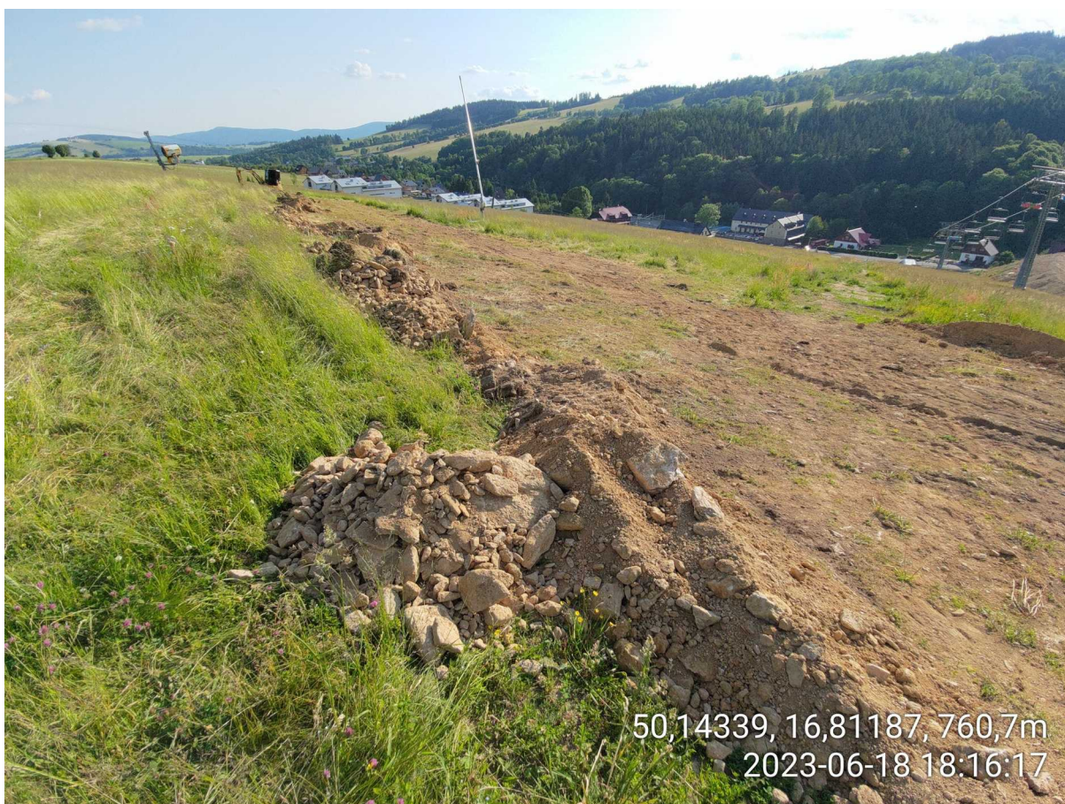
Obrázek 4: Malý bagr provádějící zemní práce.
