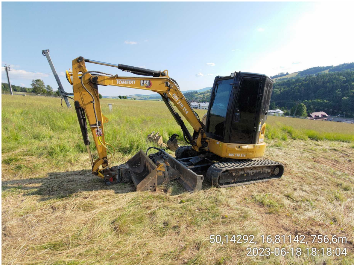
Obrázek 5: Malý bagr provádějící zemní práce.
