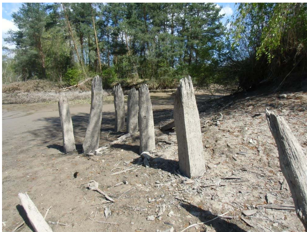
Zbytky pilířů ještě před jejich vytažením z bahna na jaře 2016. Foto I. Vaňousek
